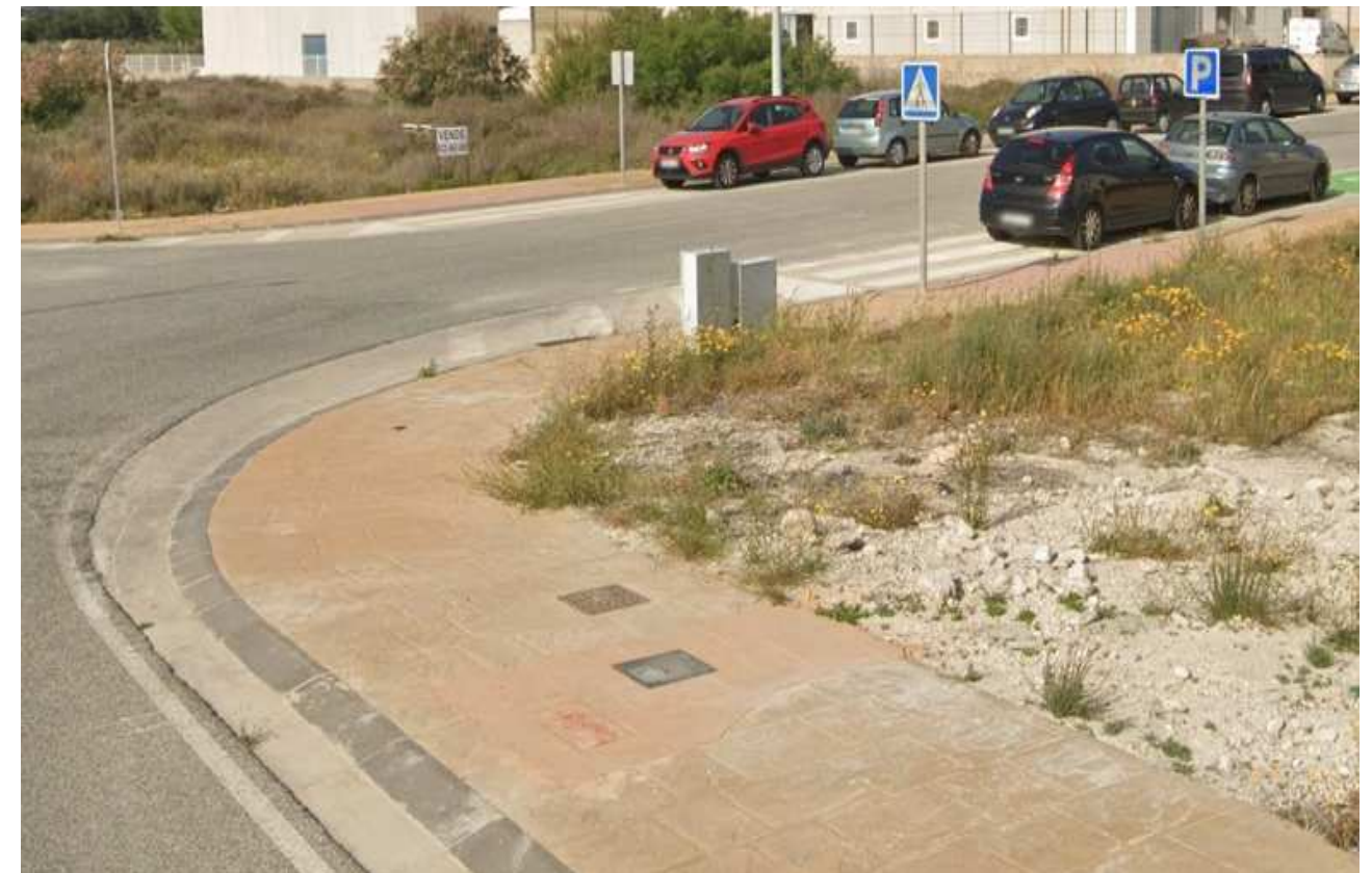
Figura 44. Vista de acerado existente en el polígono
