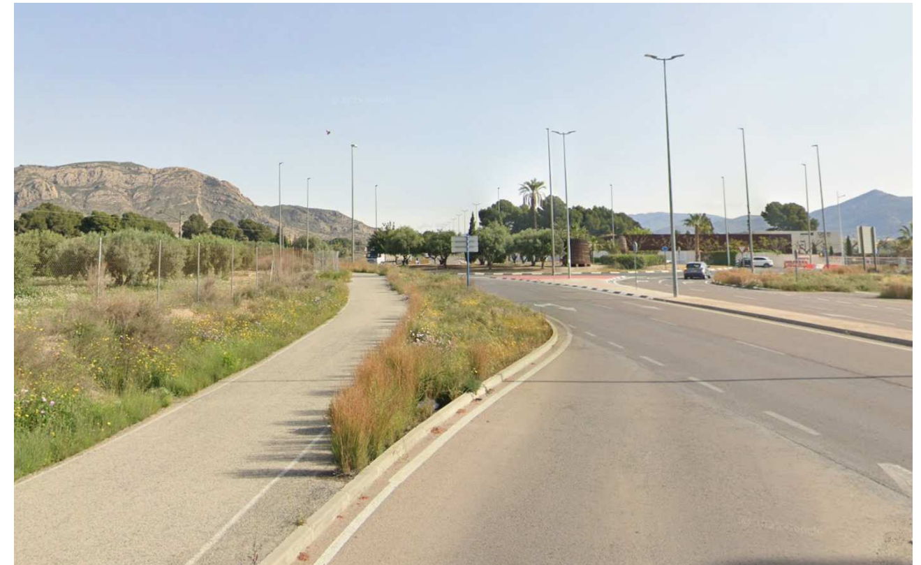
Figura 46. Vía ciclista exterior paralela a CV-835 y próxima al acceso noroeste del polígono
